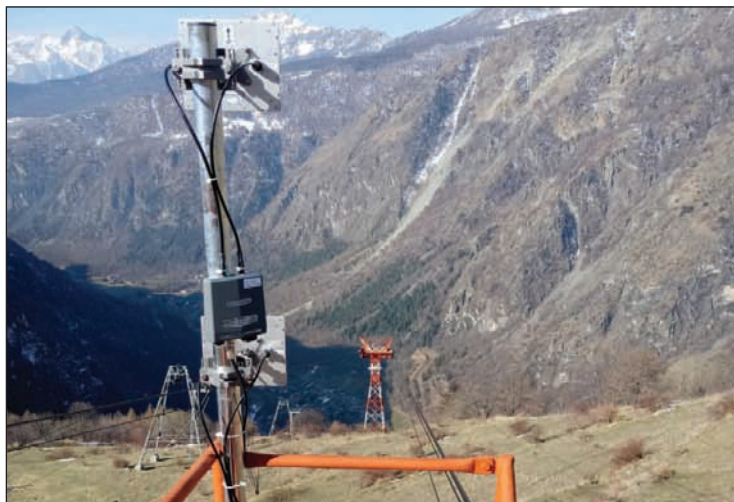
Apparati RF posizionati sul sostegno verso monte che permettono di irradiare il trackage per la comunicazione terra/bordo e connettere le stazioni
